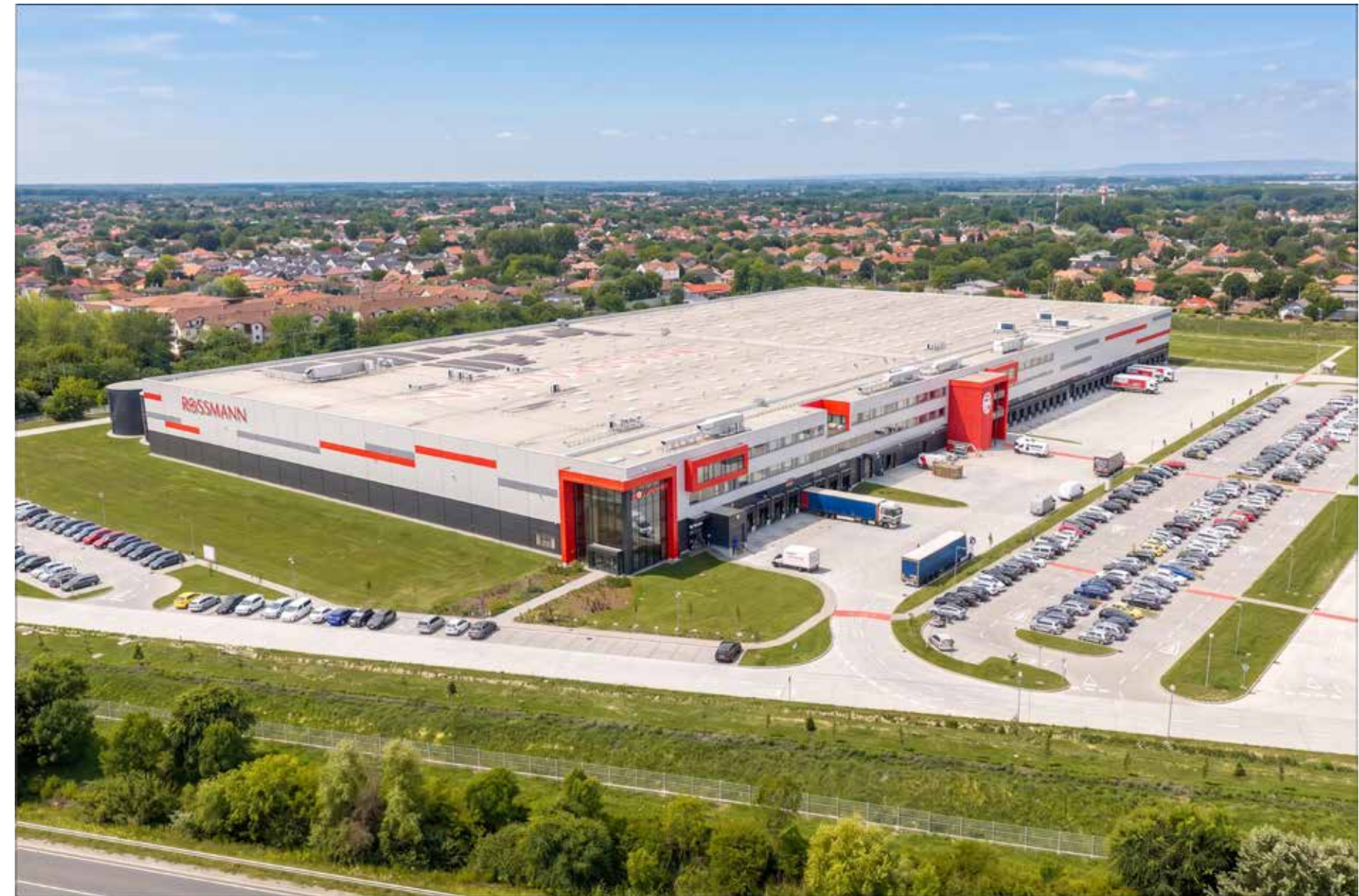
A HQ az Üllőn felépült, TH-Stúdió Építész Iroda tervezte modern logisztikai központ szerves része
